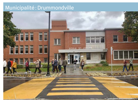
Fig. 2 - Traverse piétonne surélevée devant une école
