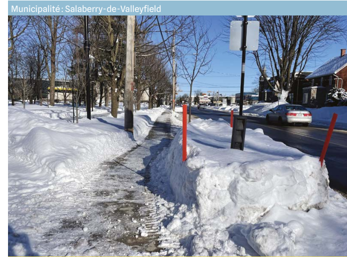
Fig. 11 - Trottoir déneigé, rectiligne avec saillie de trottoir
