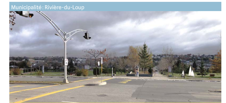
Fig. 14 - Traversée piétonne surélevée avec îlot refuge
